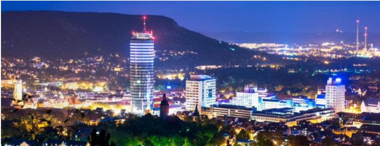
Der Intershop-Turm präsentiert sich als Leuchtturm des Ostens. Foto: Tino Zippel
